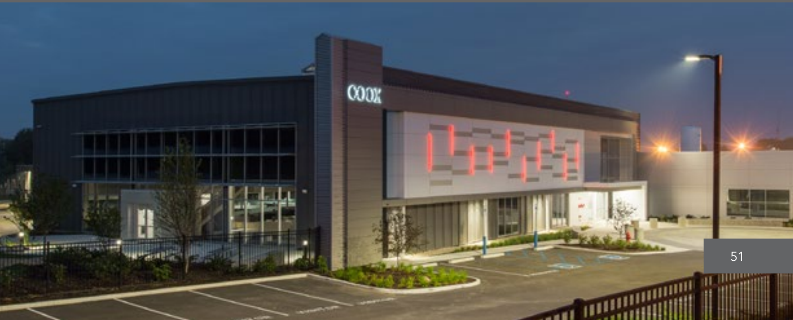
曲克再生科技公司（美國印第安那州印第安那波利斯市）
